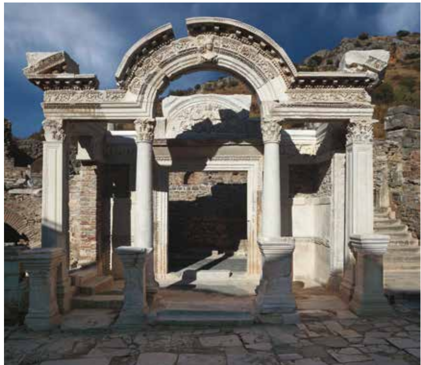
Abb. 3: Der sog. Hadrianstempel nach der Restaurierung (2014)
